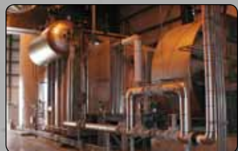
A Victory Energy HRSG installed at an ethanol plant.
